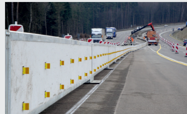
Großflächiger Wasserablauf von je 8m Länge pro 10m-Element ist bei ProTec-Systemen gewährleistet.
