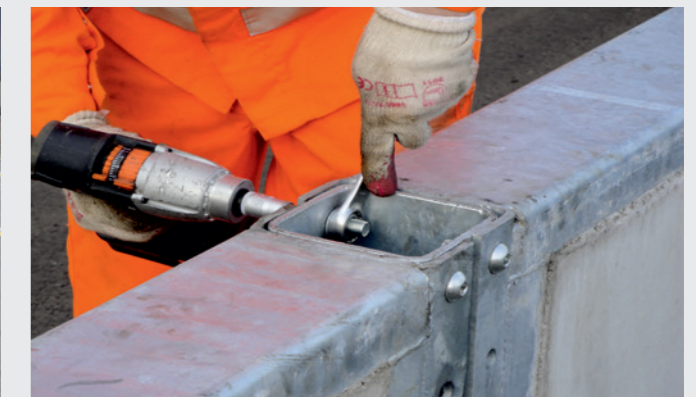
An jedem Element ist immer ein Ständer montiert. Alle 10 Meter werden nur noch zwei Schrauben eingesetzt.
